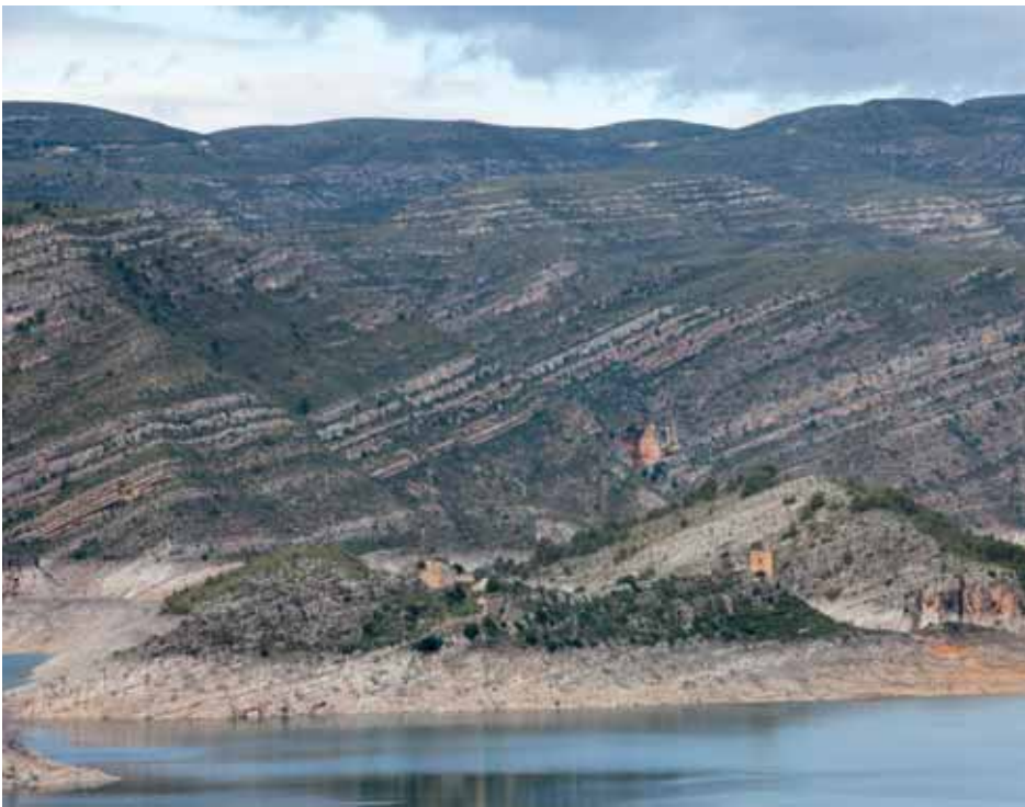
Macizo rocoso en el vaso del embalse. Vista de la Torre Vigía
